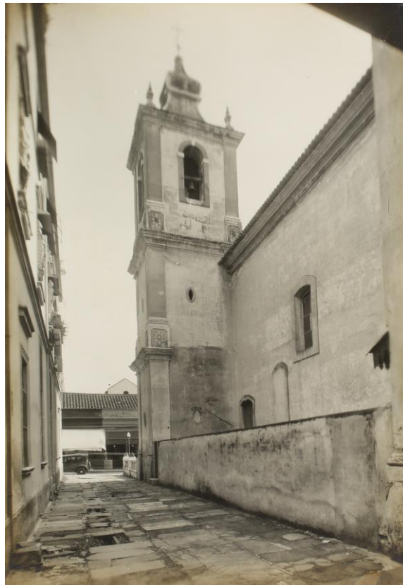
Figura 03- Igreja Nossa Senhora do Rosário. vista lateral. Arquivo Digital IPHAN
